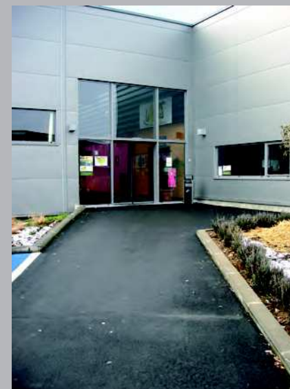
✓ Voie d'accès de largeur suffisante.
