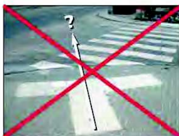
Figure 10: les dalles striées doivent indiquer l'axe de la traversée ! © GAMAH
