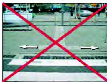
Figure 6: les dalles à protubérances doivent être placées sur toute la largeur de la traversée. © GAMAH
