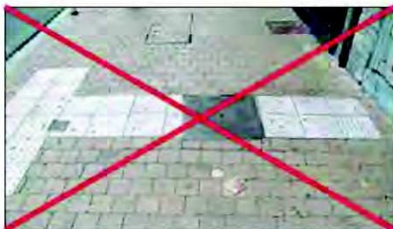
Figure 23 : dalle recouverte d'une plaque d'égout.
