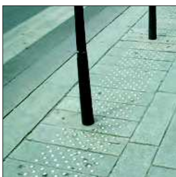
Figure 1: les dalles de type « rivet ».
