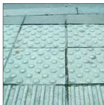
Figure 3: les dalles de béton (30 x 30 cm). © GAMAH
