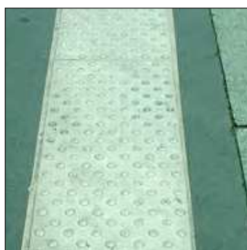
Figure 2: les dalles collées.
