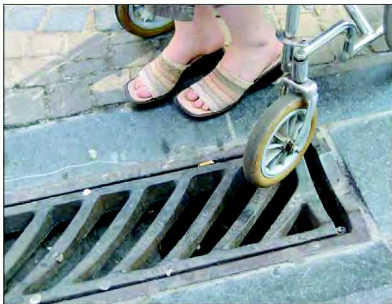
Figure 5: les avaloirs constituent un réel danger pour les personnes à mobilité réduite. © Access+
