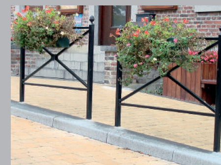
✔ Barrière contrastée et hauteur conforme
