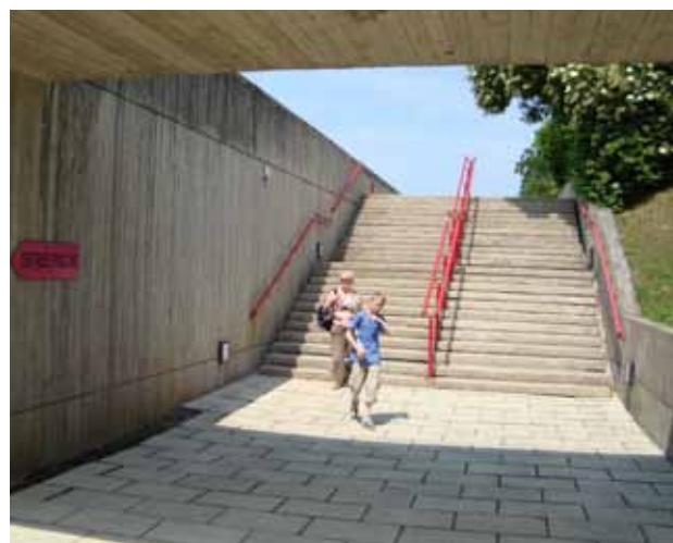
Main courante centrale contrastée permettant la canalisation des flux et un appui possible de part et d'autre
