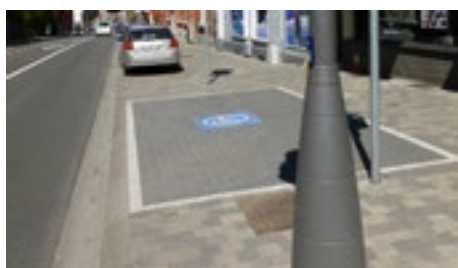
✓ Surélévation de l'emplacement réservé au niveau du trottoir
