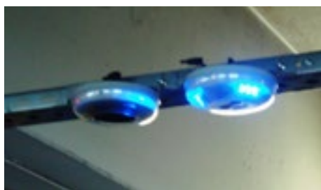
✓ Témoin lumineux au-dessus d'un emplacement réservé dans un parking intérieur
