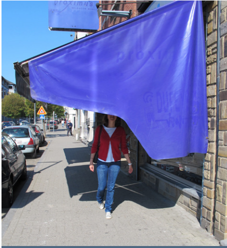
❌ Tente solaire avec parois latérales réduisant la hauteur de libre passage
