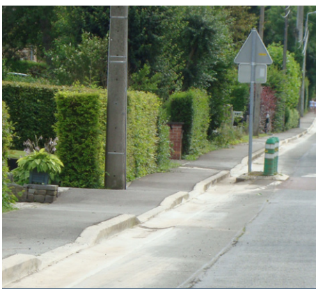
❌ Pas de maintien de l'horizontalité du trottoir - Effet d'ondulation
