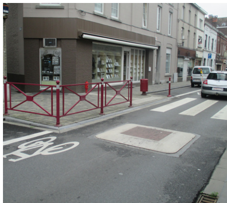
✓ Traversée piétonne sécurisée entre autres grâce à une avancée de trottoir
