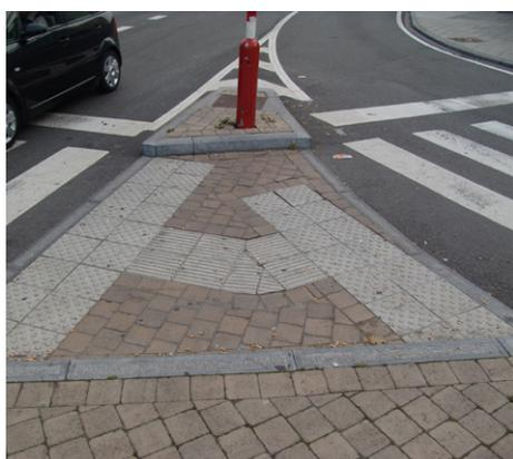
✓ Îlot sécurisé par un dispositif podotactile
