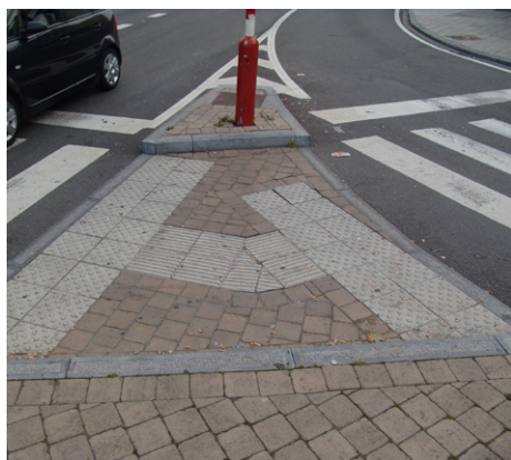
✓ Îlot sécurisé par un dispositif podotactile
