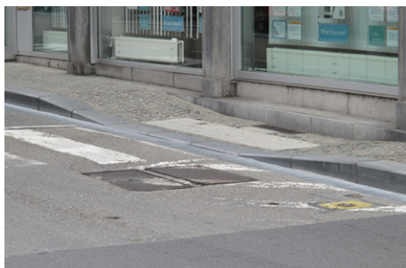
✓ Traversée piétonne aménagée avec une inflexion perpendiculaire
