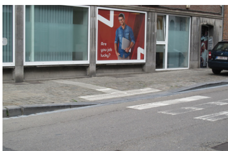
✓ Traversée piétonne aménagée avec une inflexion parallèle
