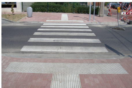
✓ Traversée piétonne équipée d'un dispositif podotactile
