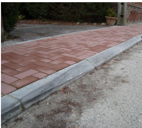
✅ Trottoir garantissant un accès carrossable grâce à la présence de bordures à grand chanfrein
