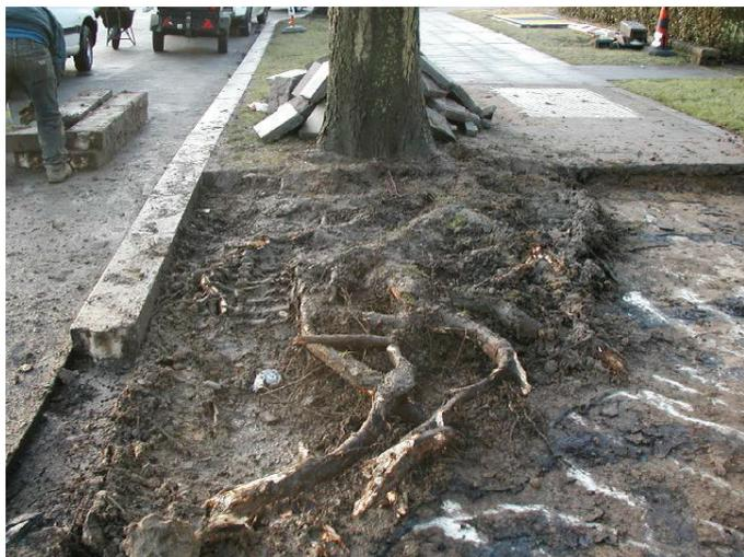
*Photos 4 et 5 : Conséquences sur le système racinaire d'aménagements de site propre ou de réfection de trottoir*
