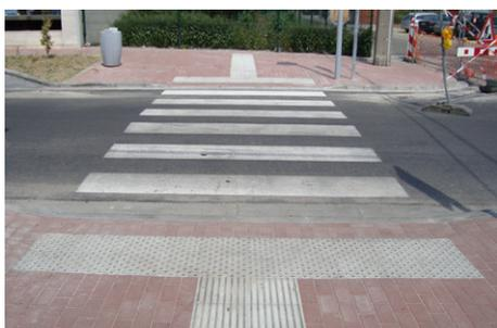
✓ Traversée piétonne équipée d'un dispositif podotactile
